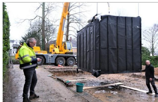
Sur chantier, les modules sont grutés et déposés dans les fondations.
