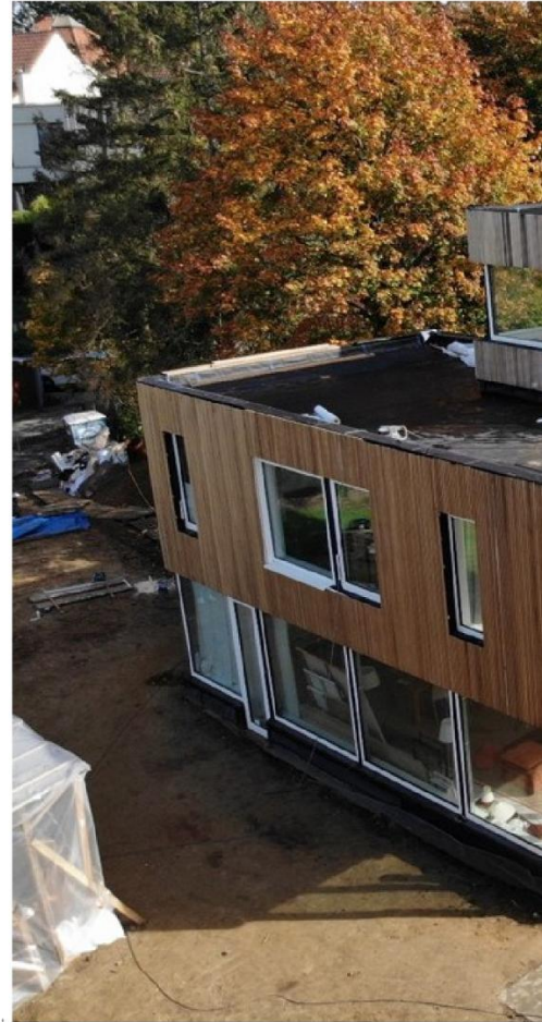
Construction d'une maison unifamiliale de 250 mètres carrés en partenariat avec le bureau d'architecture JPHA
